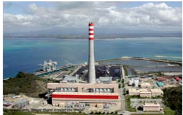
Pagbilao Plant located in Barangay Ibabang, Pulo, Pagbilao, Quezon
